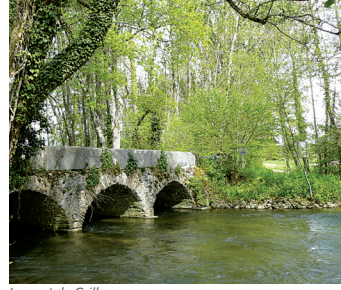
Le pont de Grilly
